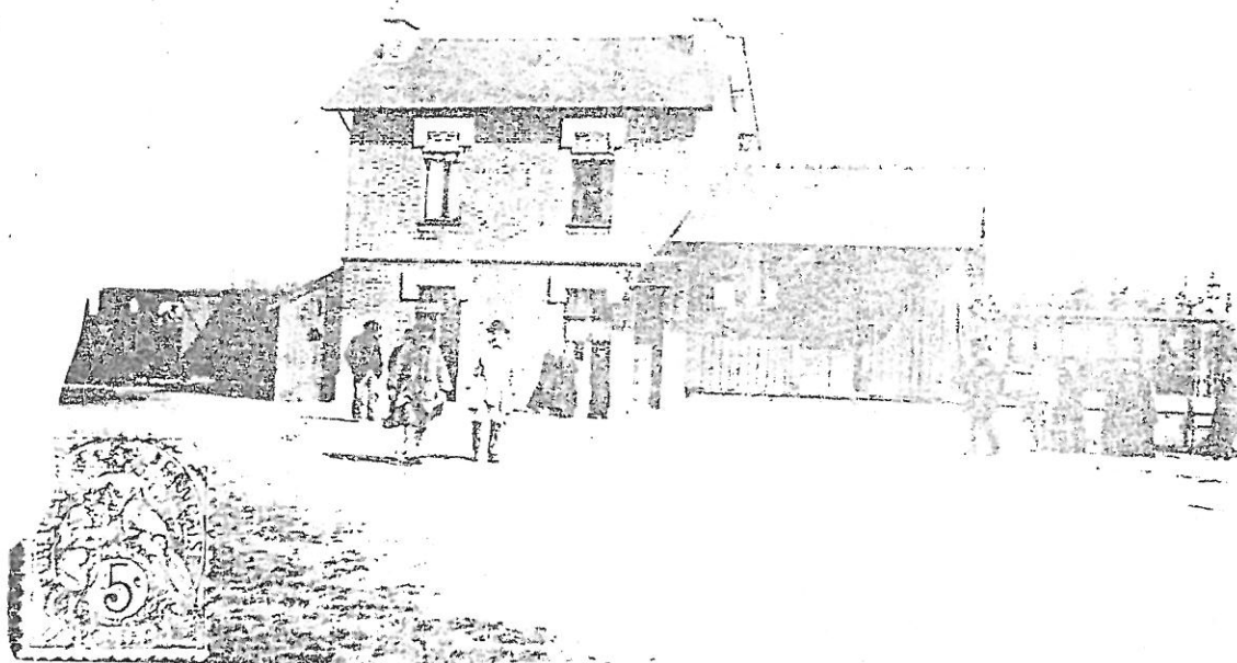
4941. Beißen (Steinbau). - La Gare de Stein.
