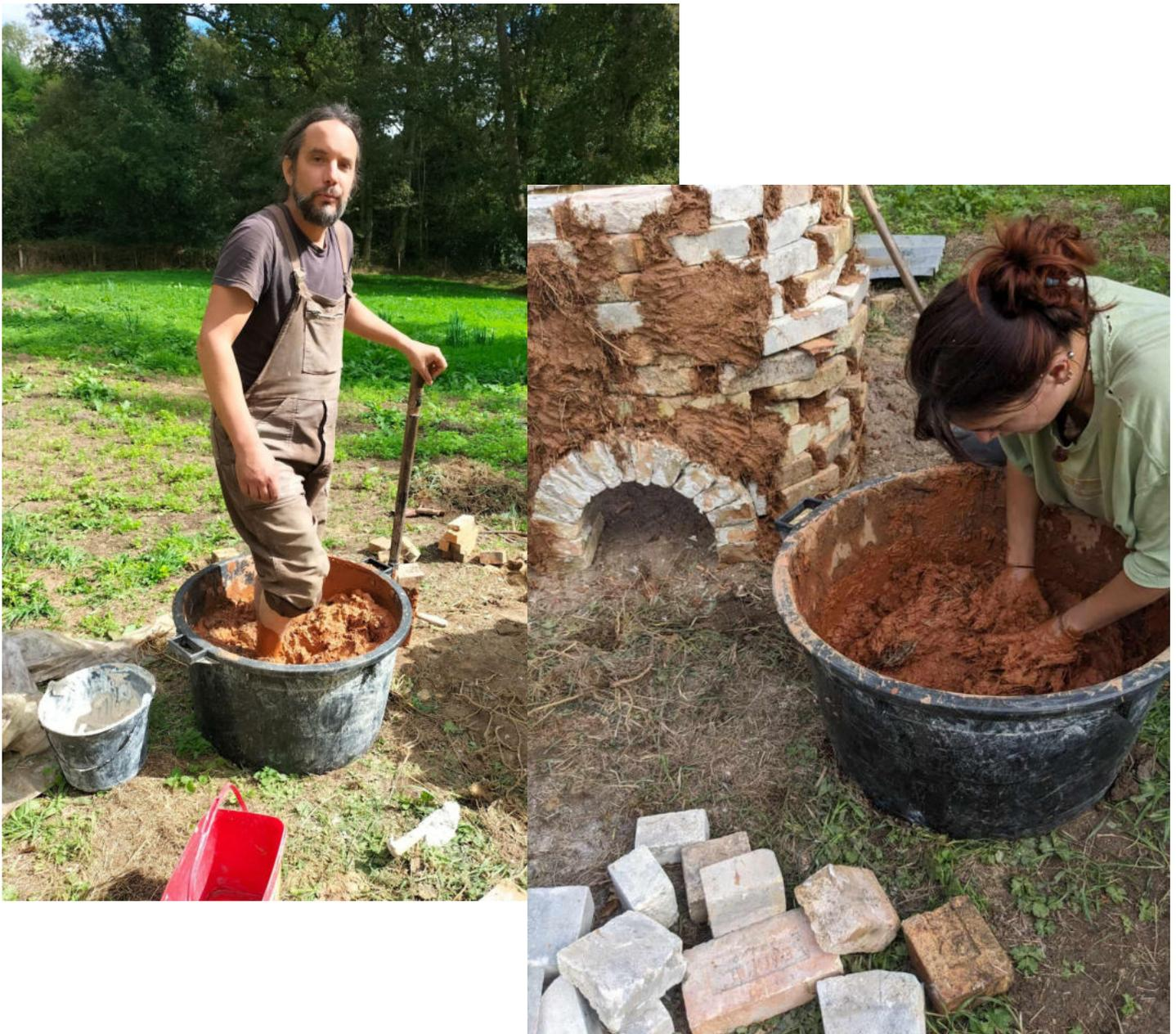
Pour les proportions, il ne faut pas mettre trop de paille sinon le mélange est trop épais et pas mettre trop d'eau sinon ça devient trop liquide. Il faut arriver un mélange où l'argile est suffisamment compacte dans la main et qu'elle se maintient.
